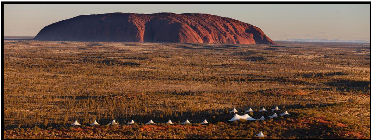
Location: Yulara - Longitude 131 Hotel Lodge - extension
